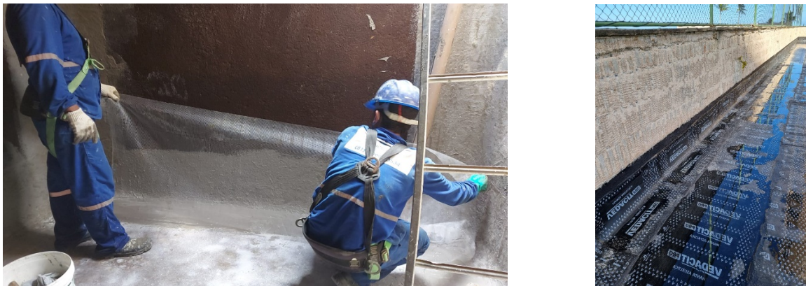
Impermeabilização e proteção de superfícies em concreto
