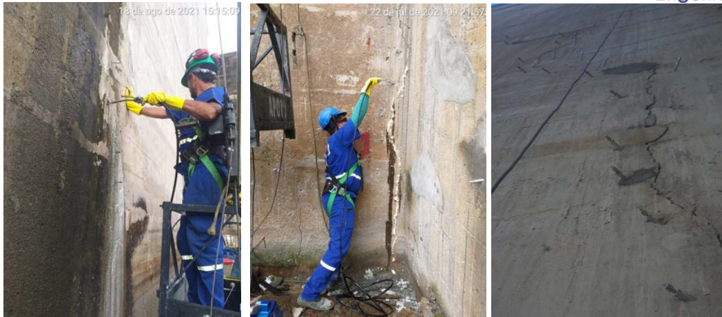
Injeção de trincas e fissuras em estruturas diversas
